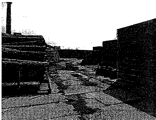
Plochy nekrytých skladů
