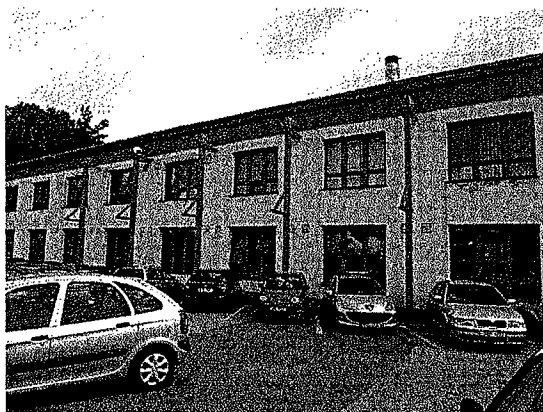
Objekt bývalého učiliště
