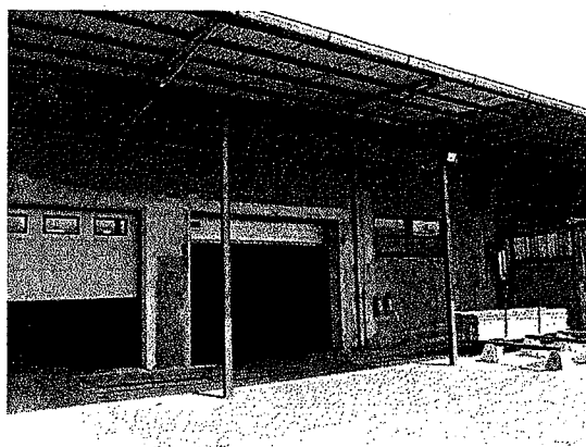
Přístavba výrobní haly II
